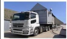
代替非常用発電機
