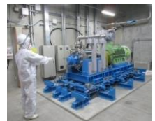
蒸気発生器直接給水用高圧ポンプ
