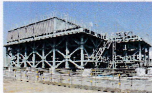
冷却塔(工事前)
