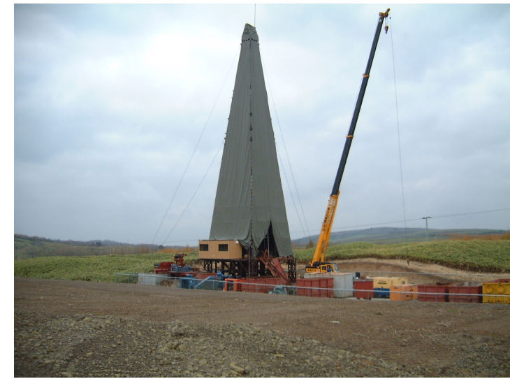
ボーリング調査 (HDB-1孔)
