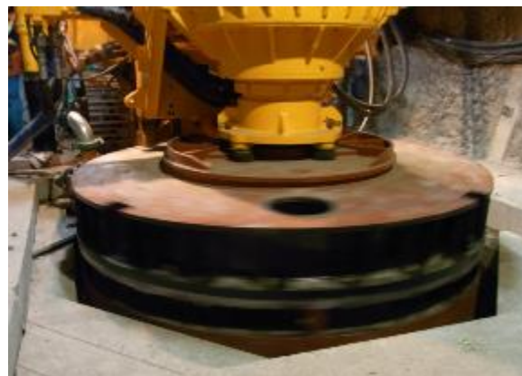
外掘りケーシング掘削状況
