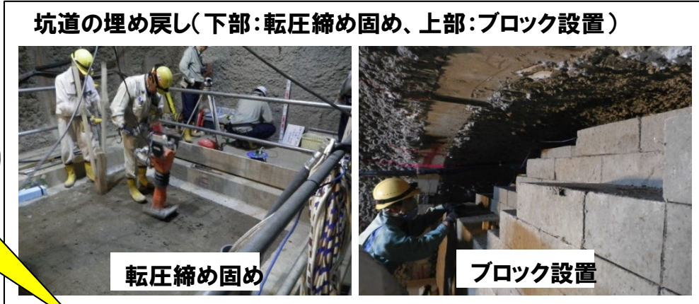
坑道を埋め戻す複数の施工方法を確認します
