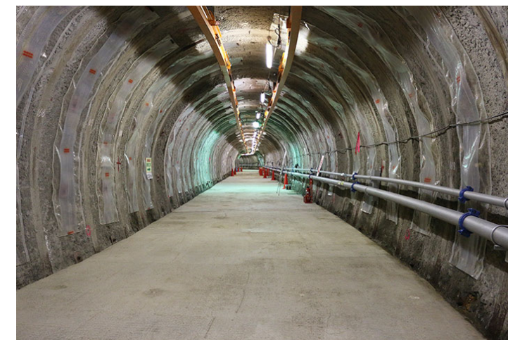
深度350m調査坑道 東周回坑道 (平成28年6月28日撮影)
