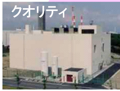
地層処分放射化学研究施設 (ホット施設)
