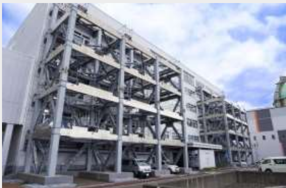
管理事務所の耐震補強
