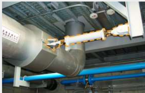
配管の耐震補強
