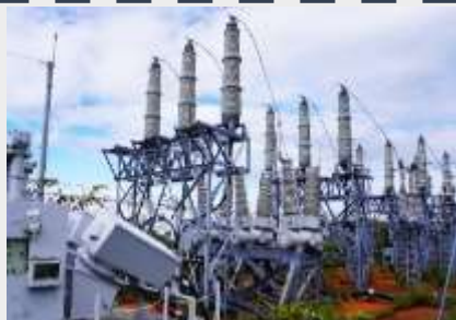
3号機の外部電源を多重化
